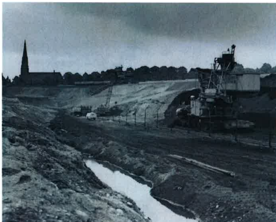
Abbildung 4: Braunkohletagebau des BKW „Glückauf“ mit der alten Kirche im Hintergrund 2
