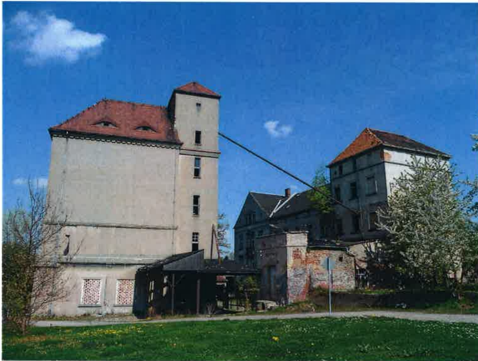
Abbildung 3: ehemalige Obermühle Olbersdorf kurz vor dem Abriss
