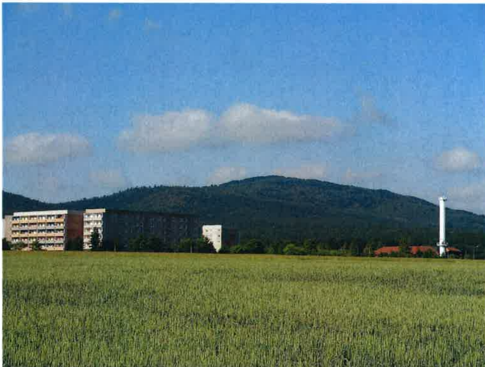
Abbildung 6: Heizkraftanlage Olbersdorf mit Teilen des industriell gefertigten Wohngebietes Grundbachsiedlung
